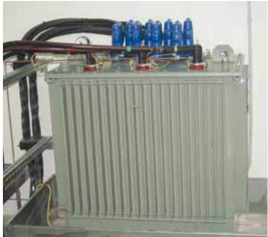
Strahlungsarmer Transformator
