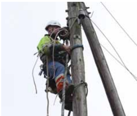
Leitung Tannenhof Freienwil einpfügen der Kabelschutzrohre, Abbruch Freileitung
