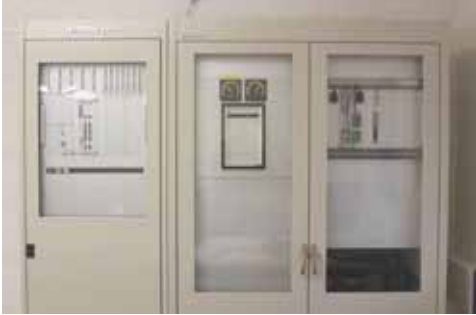
Fernwirkanlage und Steuerung Netzkommandoanlage im Werkhof
