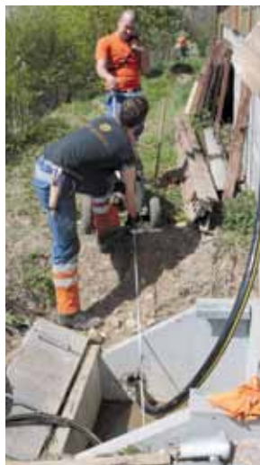
Kabelzug Klonhof, Ehrendingen
