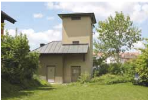
Transformatorstation Am Bach, Ehrendingen
