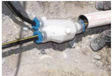
Erstellung einer Kabelabzweigmuffe
